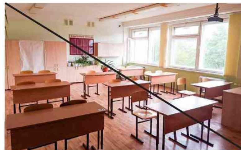
Плохо Линолеум под дерево
